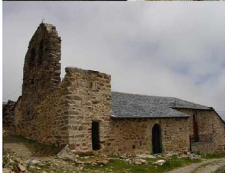
Die Wasserversorgung für die ehemalige Kirche und das H.E.E. Haus sind im Juli 2003 erschlossen worden
